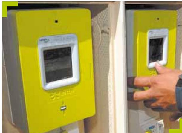
Ce compteur Linky relève automatiquement les consommations et ne nécessite quasiment plus l'intervention physique d'un technicien, permet des facturations sur la base de données réelles et non plus estimées, permet de simplifier certaines opérations de services de pilotage de la consommation sans dérangement ni rendez-vous. Il apporte également des améliorations pour l'optimisation de la gestion, de l'entretien et du développement des réseaux électriques.
