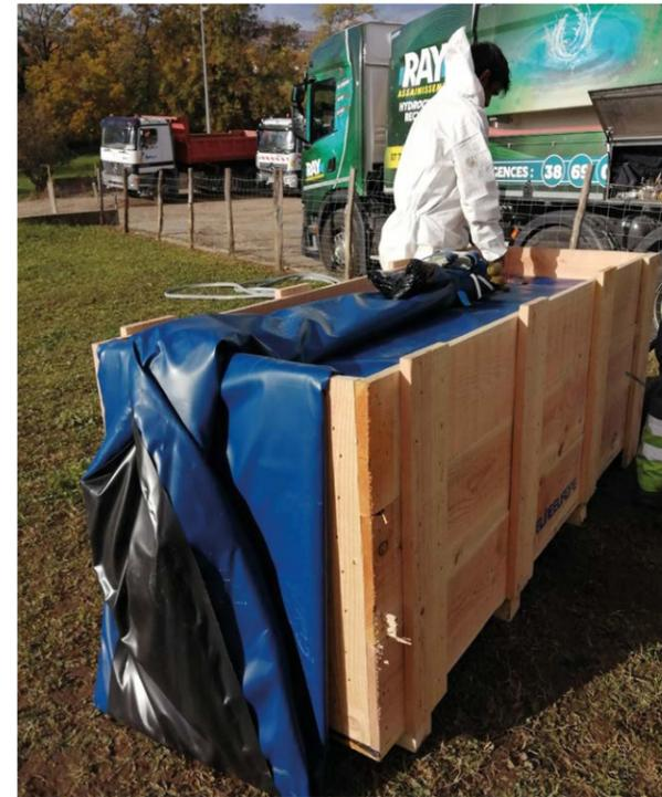
Réhabilitation de certains tronçons du réseau public d'eaux usées avec des difficultés d'accès, en domaine privé, par la technique du gainage (chemisage avec la pose à l'intérieur du réseau d'une gaine souple, ensuite durcie contre les parois de la canalisation)
