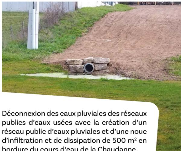
Déconnexion des eaux pluviales des réseaux publics d'eaux usées avec la création d'un réseau public d'eaux pluviales et d'une noue d'infiltration et de dissipation de 500 m<sup>2</sup> en bordure du cours d'eau de la Chaudanne
