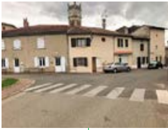
Réfection de l'enrobé rue des Entrepôts
