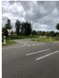
Réfection RD Col de la Luère
