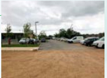
Création d'un parking à la nouvelle école maternelle
