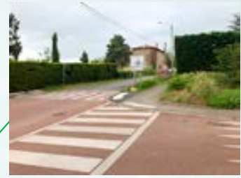
Réfection RD route de Marcy
