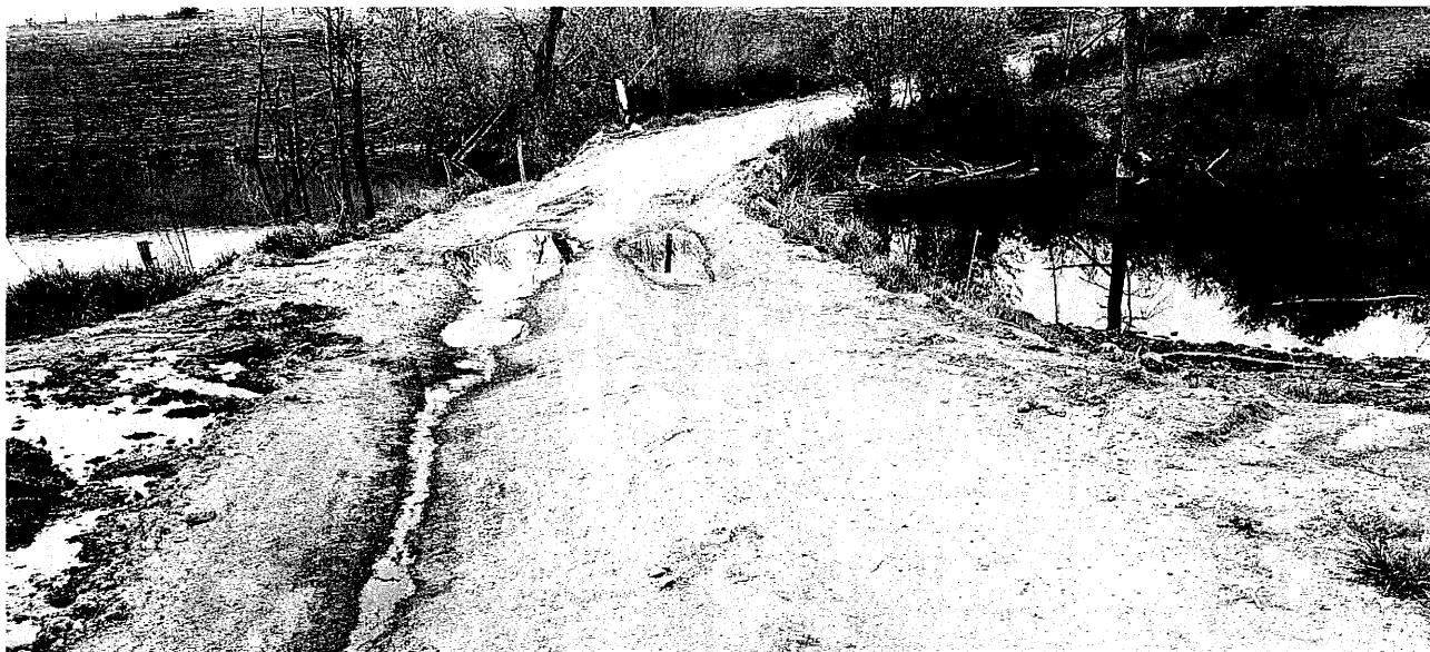
Photo 3 – chemin du Martin au niveau du franchissement de la Chaudanne
